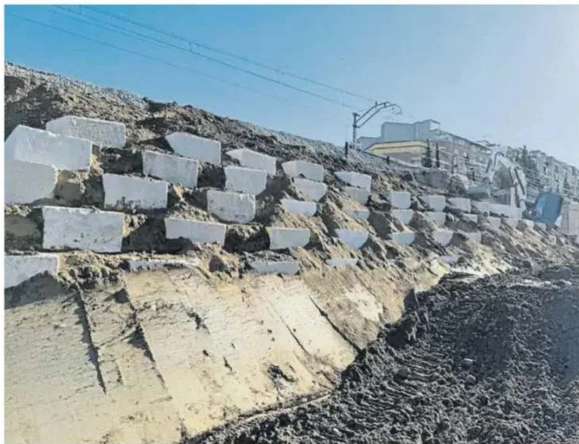
Actuación de urgencia para estabilizar el terraplén desprendido en Sant Feliu de Llobregat
