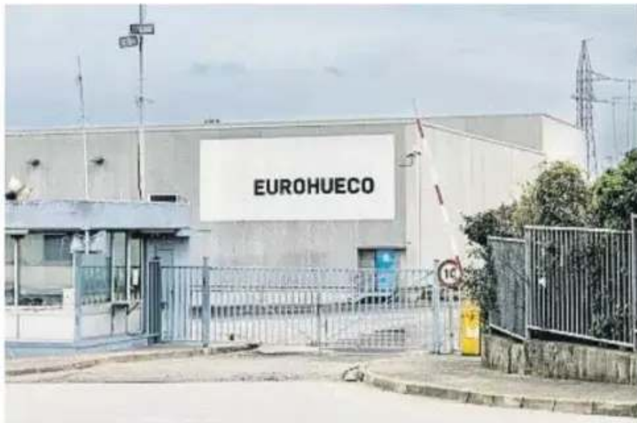
Las instalaciones cerradas de Eurohueco en Castellbisbal
